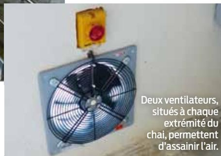
Deux ventilateurs, situés à chaque extrémité du chai, permettent d'assainir l'air.
